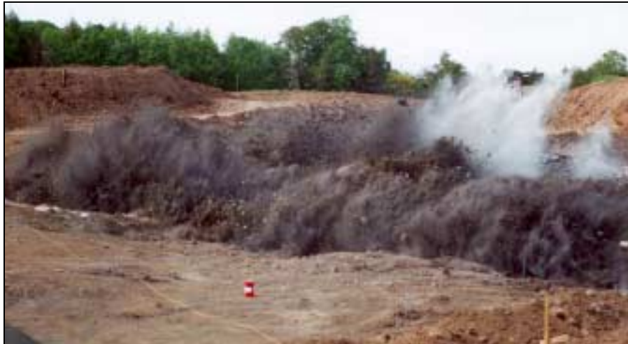
A rock face blast
